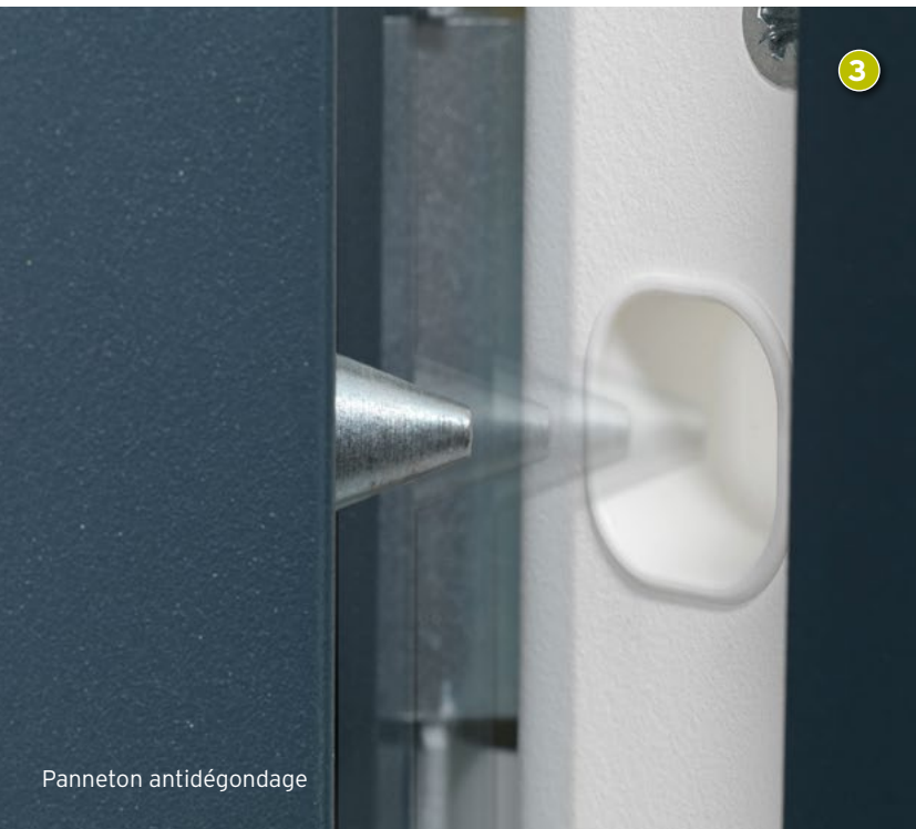
Serrure A2P avec pare-attaque intégré
